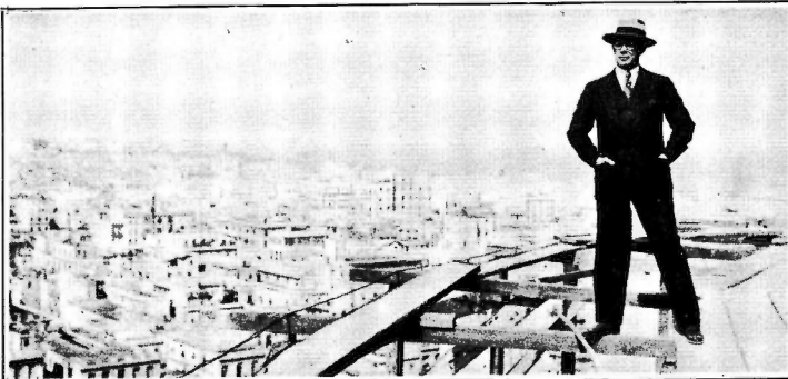
EL HOMBRE Y SU OBRA. —He aquí a Carlos Miguel de Cespedes, nuestro dinámico Secretario de Obras Públicas, contemplando La Habana desde el más alto andamio de la cúpula del Capitolio. Esta admirable fotografía fué tomada por nuestro Pegudo durante la visita que la Sociedad de Ingenieros hizo a las obras del Palacio Legislativo
